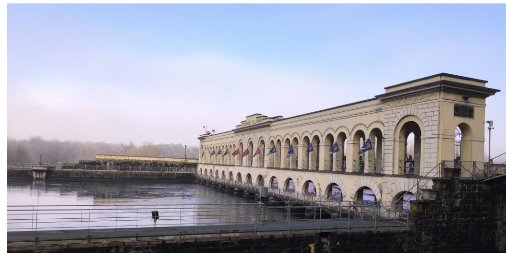
Diga del Panperduto (Consorzio di Bonifica Est Ticino Villoresi)
